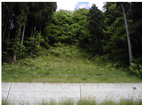
現地調査写真
