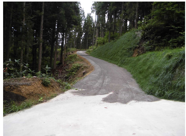
現地調査写真
