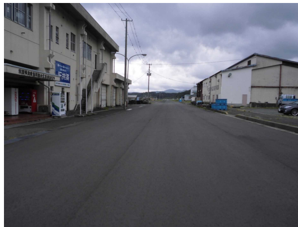
現地調査写真
