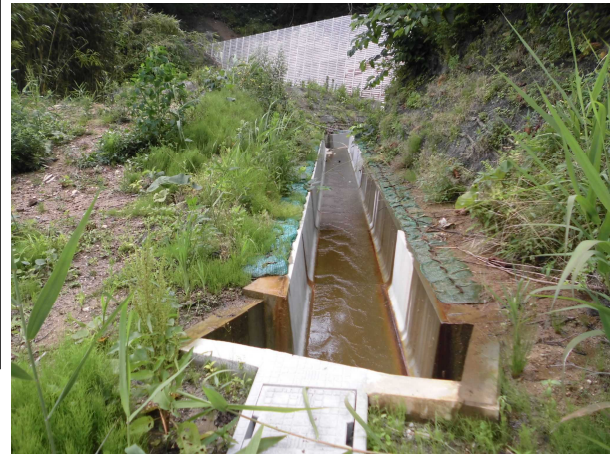
現地調査写真
